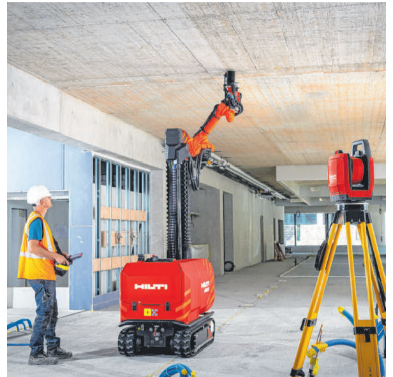
Der Jaibot ist ein semi-autonomer, mobiler Baustellenroboter für Deckenbohrungen. Er führt die Arbeiten auf der Grundlage von BIM-Daten aus.
