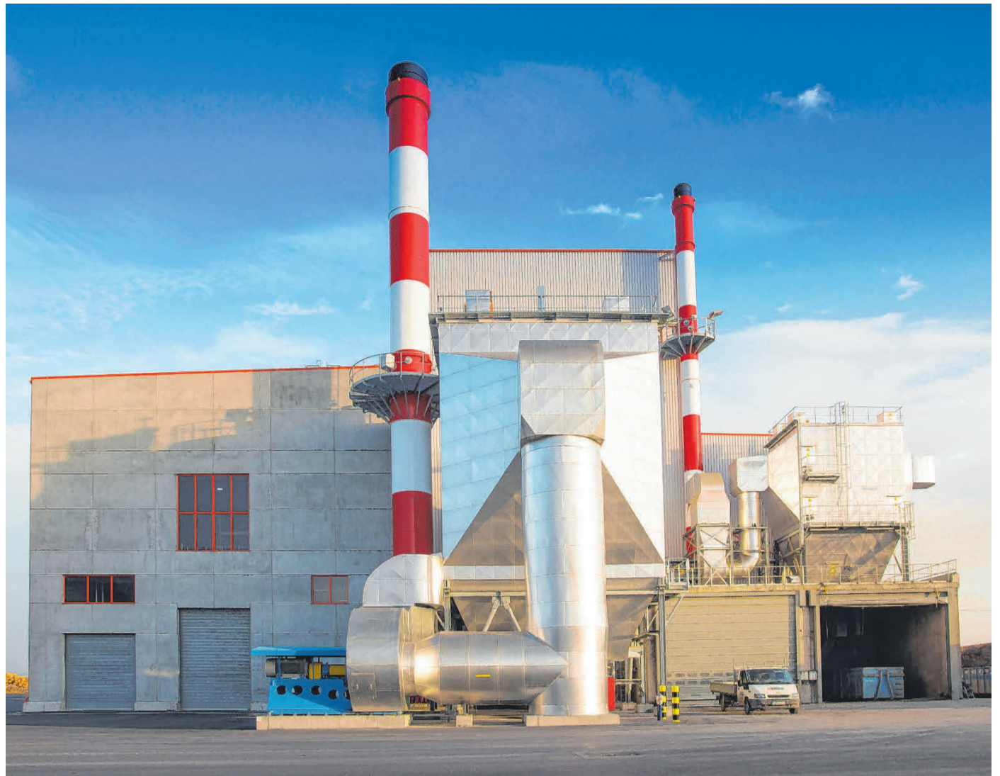
Die BERTSCHenergy-eigene Wirbelschichttechnologie macht aus Reststoffen wertvolle Brennstoffe.
